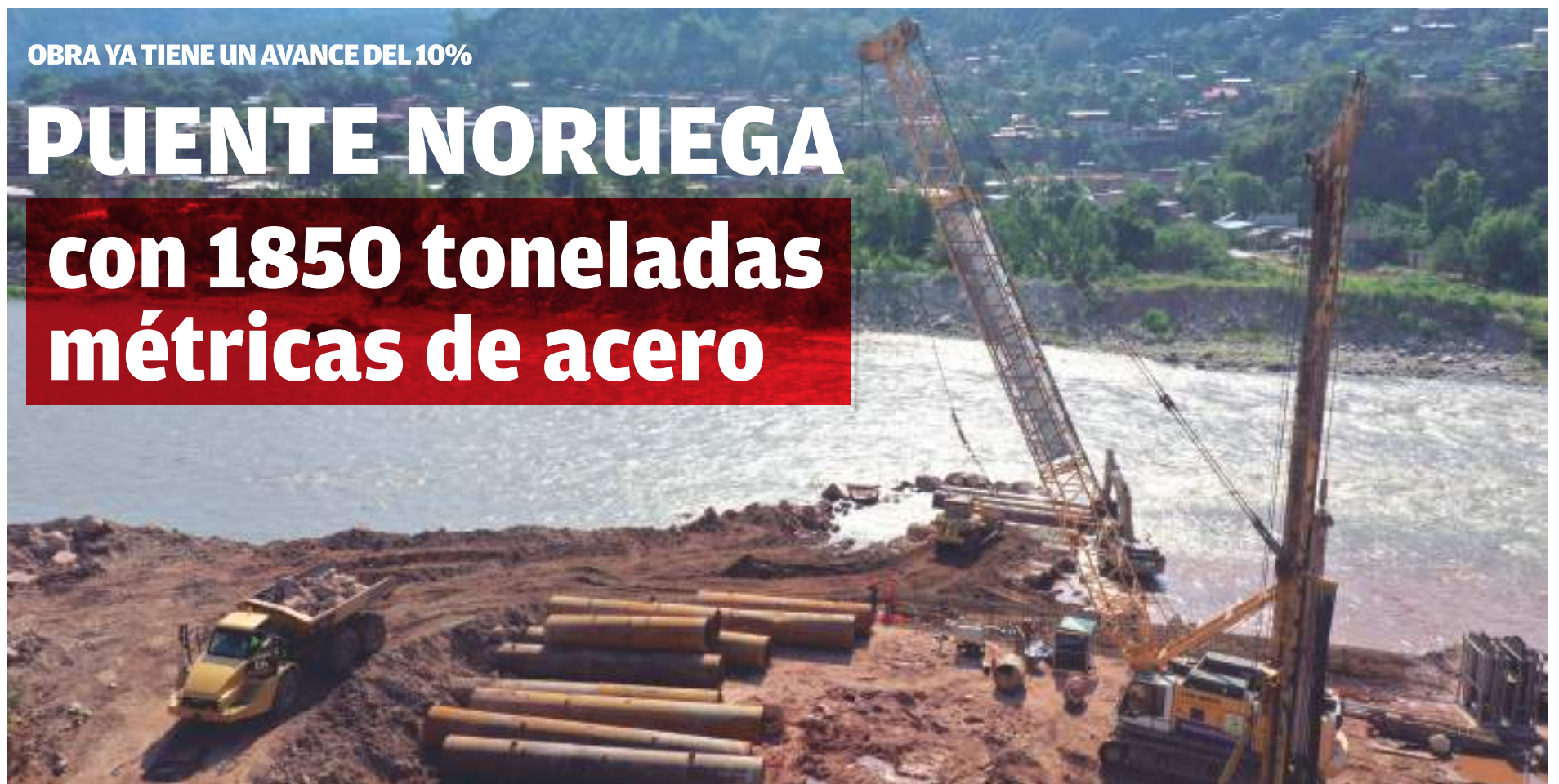
La construcción requiere de 100 fundas de acero para los pilotes.
