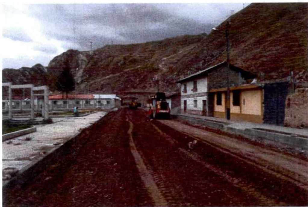
CONFORMACIÓN DE SUB BASE GRANULAR
