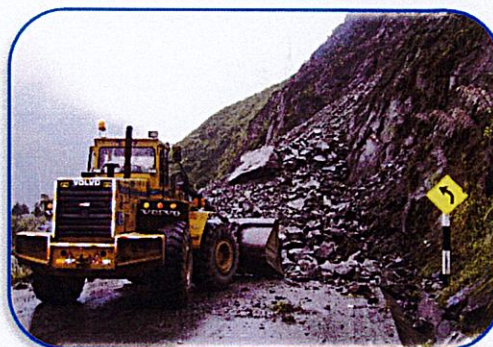
DESlizAMIENTO DE TIERRA Y ROCA EN CARPAPATA CARRETERA TARMA - LA MERCED Y TRABAJOS DE LIMPIEZA DE LA VIA
