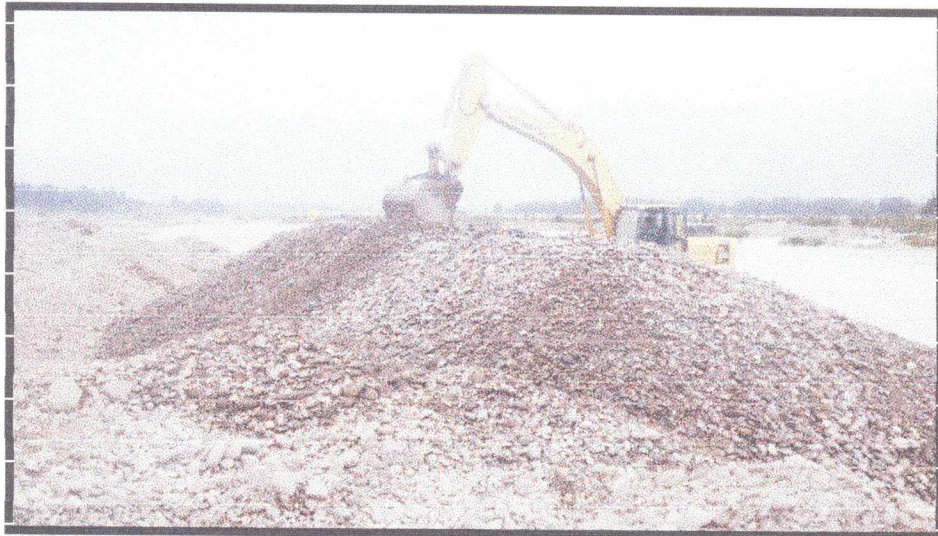
FOTO N°03: EXCAVADORA CONFORMANDO EL DIQUE
