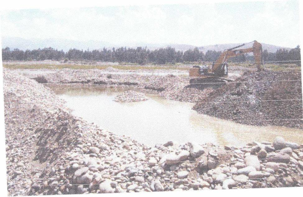
Se realiza la descolmatación del Rio Mantaro Sector Chongos Bajo en un ancho de 77.00 m, una longitud de 1,600.00 m y con una profundidad de 1.00 m de material colmatado.
